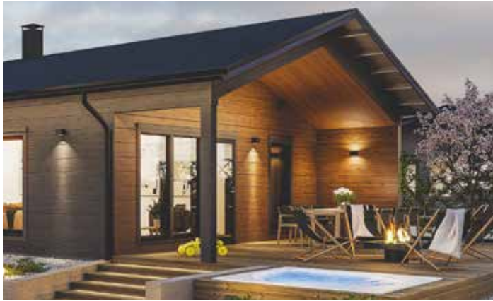
Katettu pääterassi tuo talolle näyttävyyttä ja laajentaa terassin käyttömahdollisuuksia.
